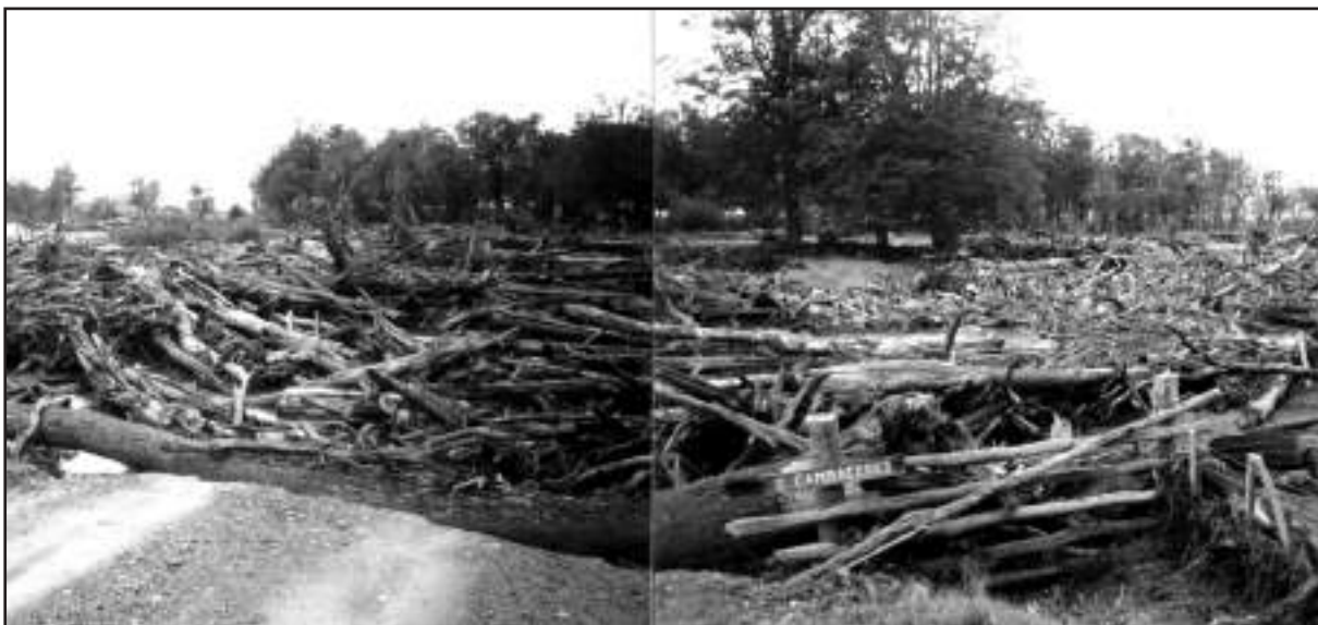
Figura 7. Gran concentración de troncos transportados por el río Cambaceres que produjeron daños en el puente de la ruta Provincial en el año 2000.
